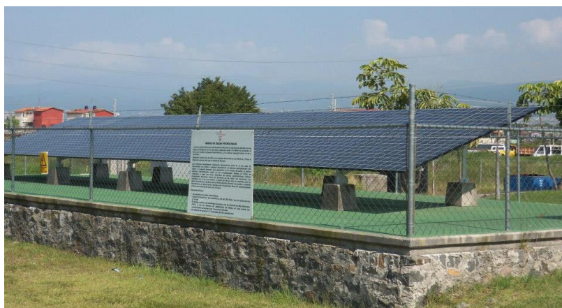
Figura 8.12 Instalación de paneles fotovoltaicos en la Universidad Politécnica del Estado de Morelos (Upemor), México
